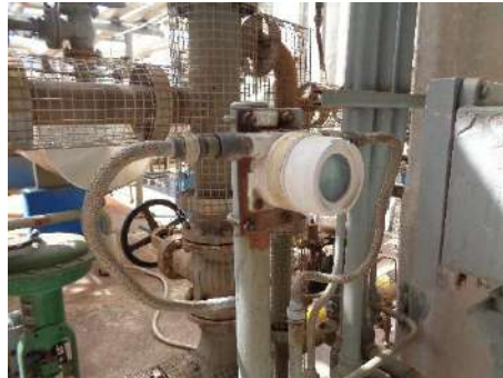
ภาพที่ 2.2-35 อุปกรณ์วัดอัตราการไหล ความดันและอุณหภูมิ บริเวณพื้นที่กระบวนการผลิต
