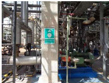
ภาพที่ 2.2-32 ฝักบัวฉุกเฉิน (Emergency Shower) และที่ล้างตา (Eye Washer)
