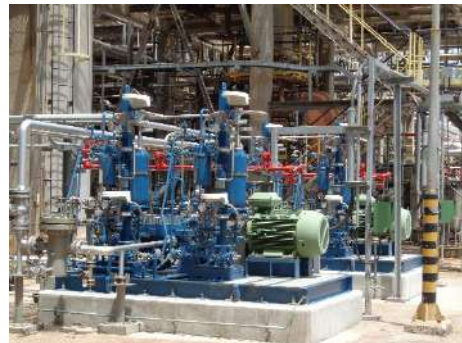
ภาพที่ 2.2-2 ปัมป์ที่มีระบบป้องกันการรั่วไหล 2 ชั้น (Double Mechanical Seal)
