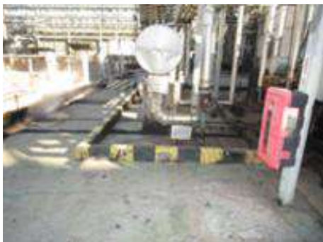
ภาพที่ 2.2-29 คันคอนกรีตรอบถังเก็บวัตถุดิบและผลิตภัณฑ์
