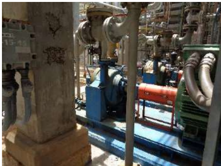
ภาพที่ 2.2-2 ปัมป์ที่มีระบบป้องกันการรั่วไหล 2 ชั้น (Double Mechanical Seal)
