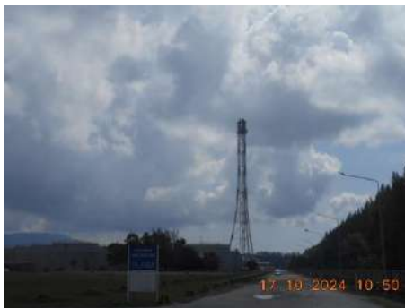
ภาพที่ 2.2-3 หอเผาที่จ้งระดับเหนือพื้นดิน (Elevated Flare)
